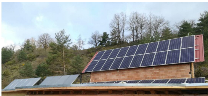
Ezkerrean eguzki-kolektore termikoak eta eskuinean panel fotovoltaiakoak. Agotzenea ekohezkuntza guinea
